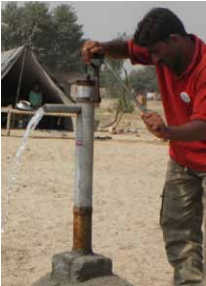
Helfer installierten Pumpen für die Grundwasserversorgung.
