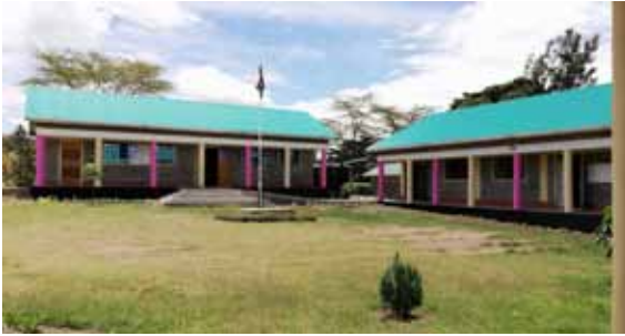
Die MIRISA-Primary School ist fertiggestellt
